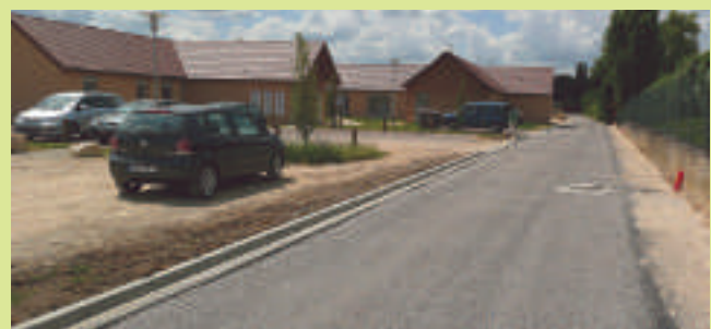
Un "gravillonnage" a été réalisé. L'enrobé sera posé avant la fin juillet.
