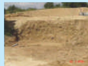
Terrassement du bassin d'orage
