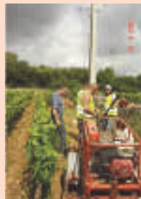
Dévidage du câble haute tension
