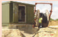
Dévidage du câble haute tension
