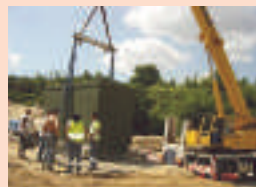
Installation du transformateur EDF sur sa plateforme
